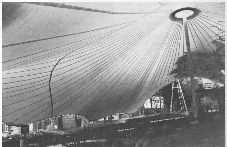
chung. Es handelt sich um eine Dachhaut von etwa 1000 m<sup>2</sup> aus transluzentem Sarnafil S, das aus einem hochfesten PES-Gittergewebe besteht, das mit PVC beschichtet ist. Die ganze Dachhaut wurde in Sarnen nach computerberechneten Schnittmusterplänen zugeschnitten und zu einem einzigen Stück verschweisst. Diese Haut wurde unter Schonung der verletzlichen Gletschermühlen (Sandstein) und des Baumbestandes am Zentralmast aufgerichtet, an den peripheren Ankerpunkten befestigt und gespannt.
