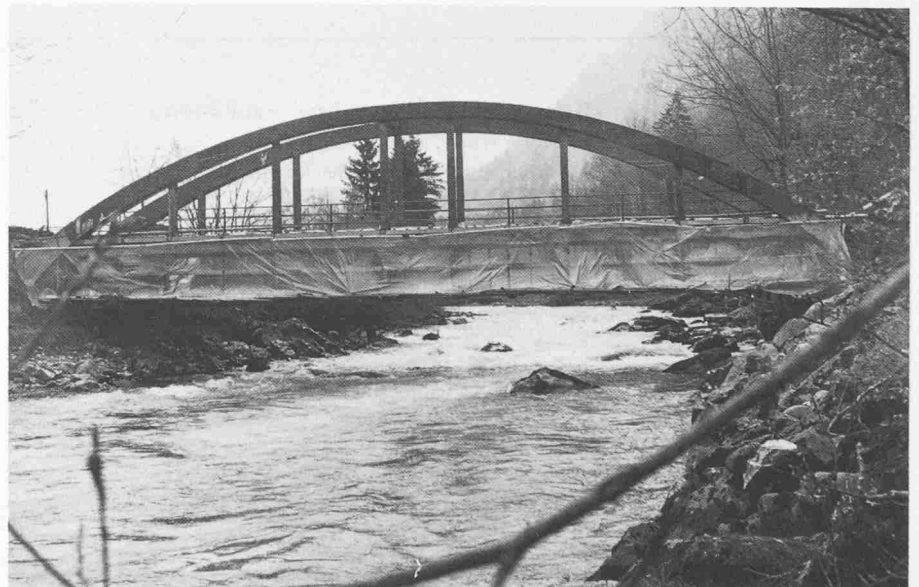
Bild 1. Gizenenbrücke mit untergehängtem Arbeitsgerüst
