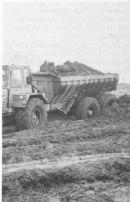
Bild 1. Auffüllarbeiten bei nassem Wetter
