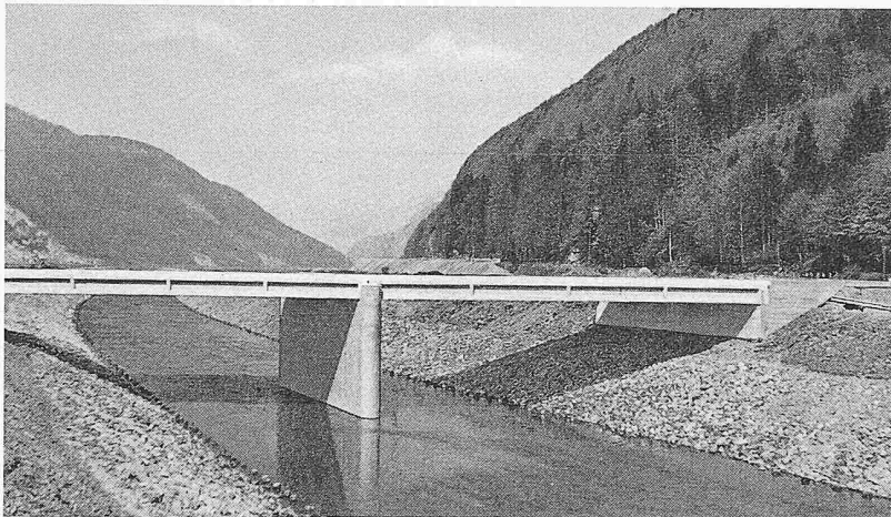
Bilder 10 und 11. Vorfabrizierte Strassenbrücke für militärische Zwecke. Träger und Fahrbahnplatten können nach allfälliger Beschädigung ausgewechselt werden
