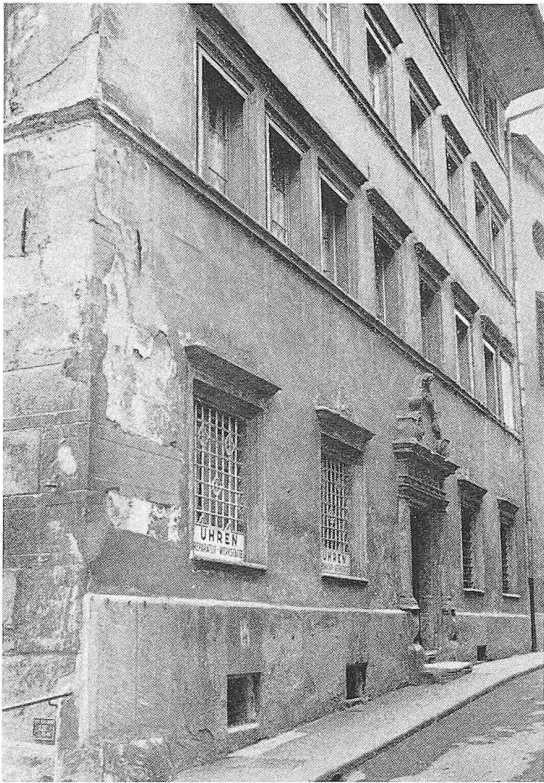
Bild 11. Fassade des am Rhyh-Hauses an der Furrengasse vor der Restauration
