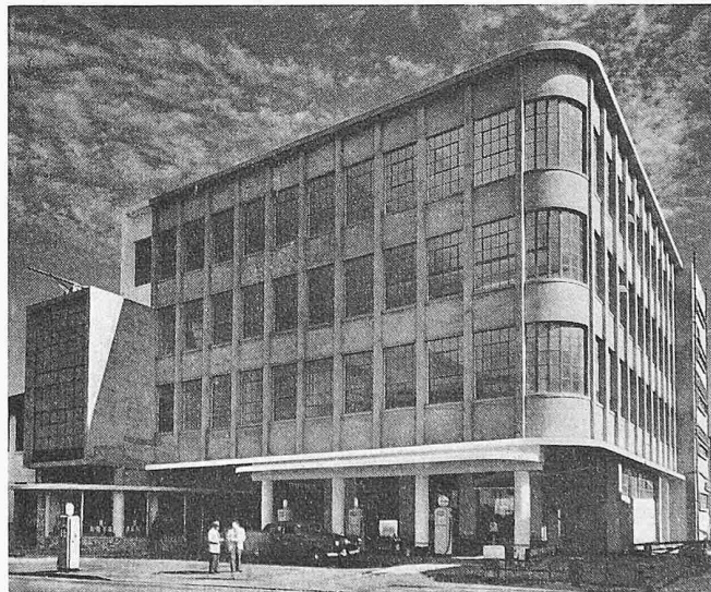
Garagebau in Cape Town, kombiniert mit Fabrikräumen in den oberen Geschossen; Eisenbetonskelett
