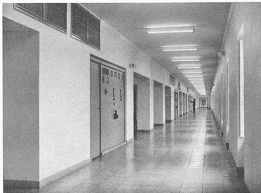
Bild 11. Blick in den Hauptbedienungsang des Inn-Kraftwerkes Stammham in Flachbauweise
