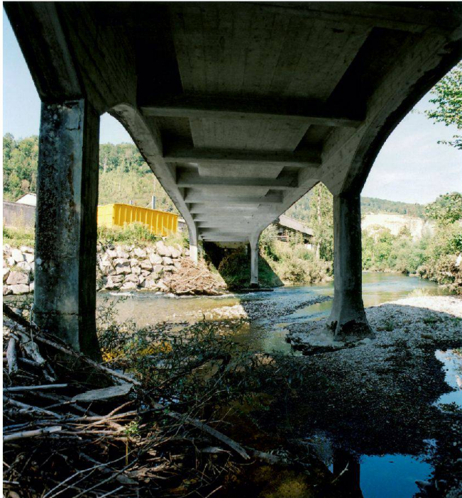
01 Birsbrücke in Liesberg Station von Robert Maillart: heutiger Zustand in der Untersicht. Die 1935 erbaute dreifeldrige Eisenbahnbrücke ist die erste der von Robert Maillart in den Jahren 1935 bis 1939 entworfenen Balkenbrücken mit Kragarmen 1 (Foto: Andreas Naegeli)
