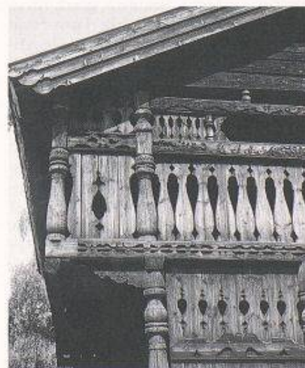
Dreidimensionales Gestalten an altem Speicher aus Norwegen
