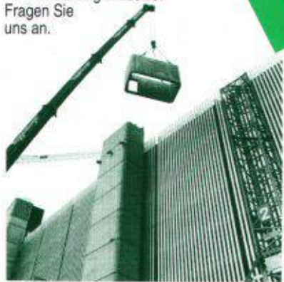
Flughafen Kloten, Parkhaus A, Aufstockung Treppenhäuser.
