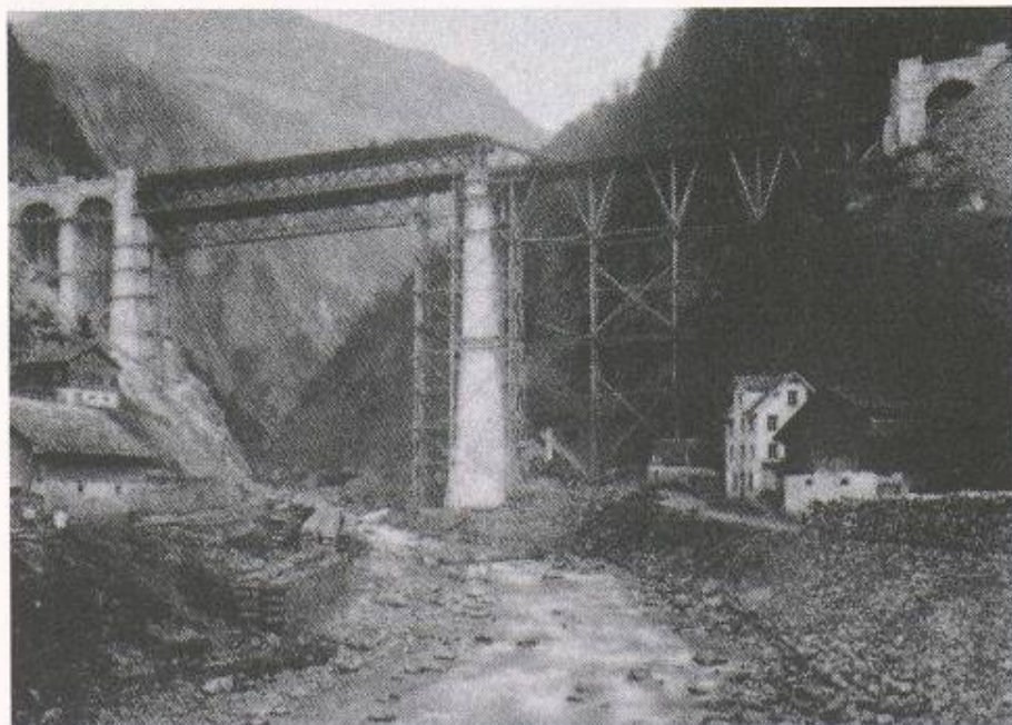
Bild 6. Bau der Kerstelenbachbrücke 1880
