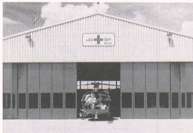
Falltorfront, Rega-Stützpunkt Gossau: Rasches Öffnen, gute Wärmedämmung, lange Lebensdauer (Alle Bilder: Jucker Tor AG, Uster)
