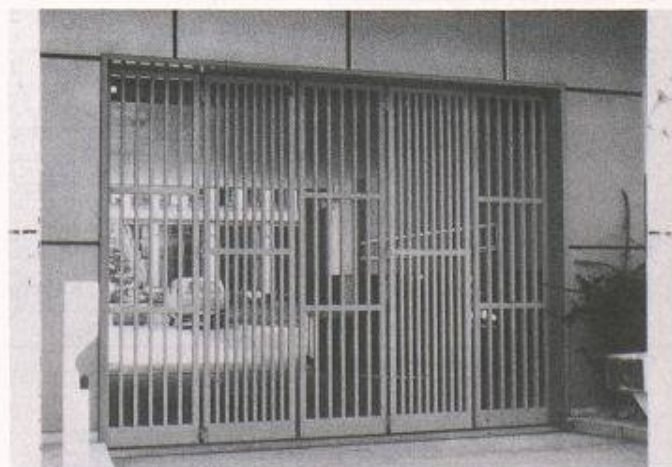
Gitter-Falltorfront als Abschluss für Sicherheitsschleuse für Geldumschlag: Robuste Bauweise, rasches Öffnen, lange Lebensdauer
