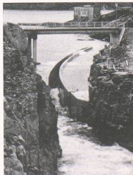
Bild 4. Tapchan von Norwegen auf Toftefallen, Norwegen. Maximale elektrische Leistung 350 kW. Blick von der Fassung zum «Tapered Channel» (Spitzkanal) und zum Ausgleichsbecken
