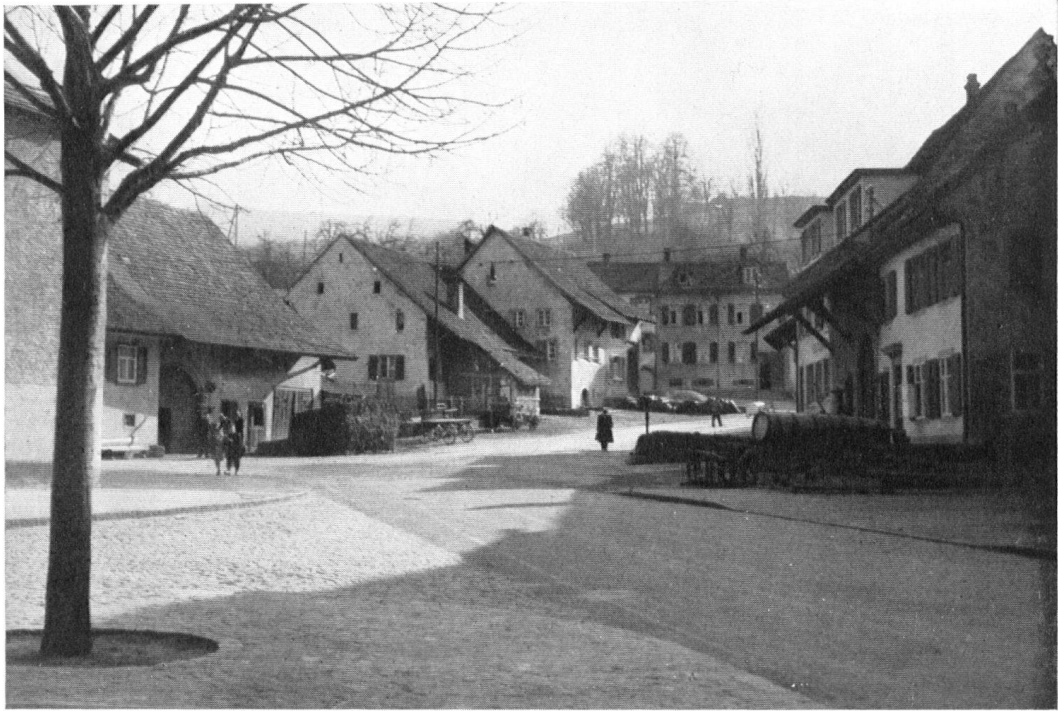
Blick in die Geispelgasse, die von der Kirche gegen die Planecke rechts unten (Seite 74) führt. Man beachte die schöne Wirkung der gestaffelten Giebel der alten Bauernhäuser. Les toits de la Geispelgasse composent une suite gracieuse.
