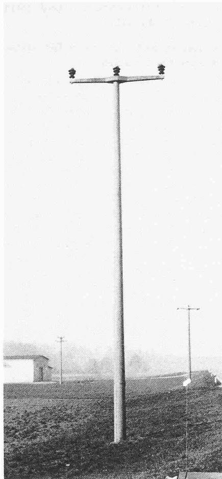
20-kV-Einfachleitung (Tragmast,  $L = 10-12$  m)
