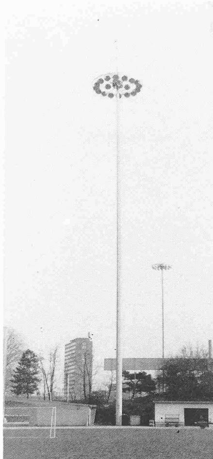
Beispiel eines Schleuderbetonmastes: Beleuchtungsmast (Länge: bis 45 m)
