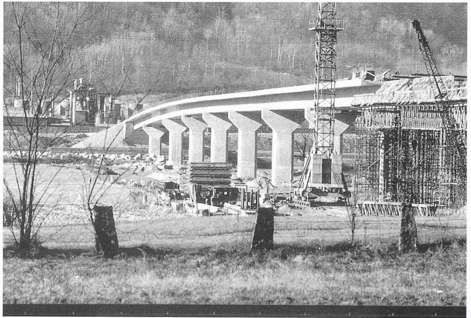
Bild 2. Ansicht der Brücke im Bauzustand aus Richtung Claro (Januar 1989)
