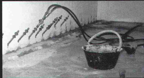
Elastische Abdichtungs-Injektion-Rascoflex in einer Zivilschutzanlage.
