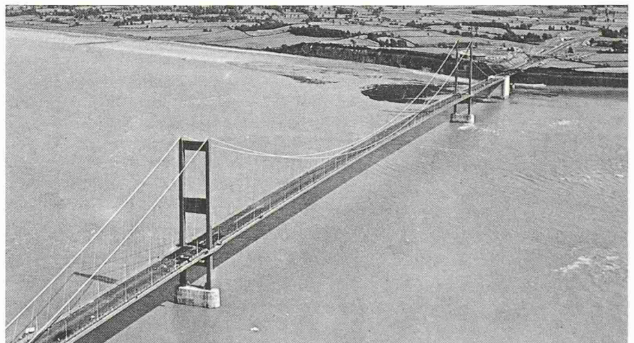
Brücke über die Severn-Mündung, Spannweite 1080 m, 1966
