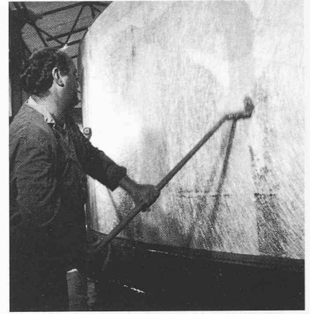
anschliessend wird die erste Glasfasermatte aufgebracht
