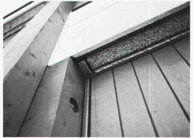
Detail Mehrzweckhalle, Haag SG
