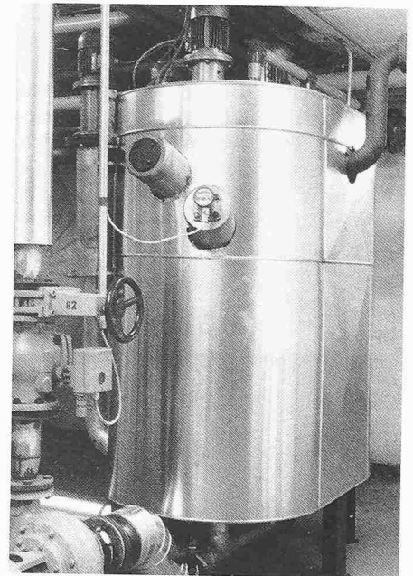
Bild 1. Sulzer Schlamm/Schlamm-Wärmetauscher
