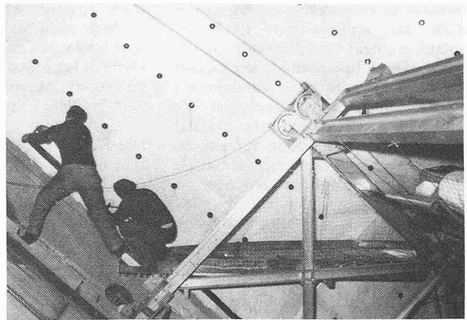
Bild 5. Spezialgerüst im Schrägschacht Bözberg. Befestigt und gesichert mit vier Drahtseilen, die mittels Felsanker im Granit verankert sind
