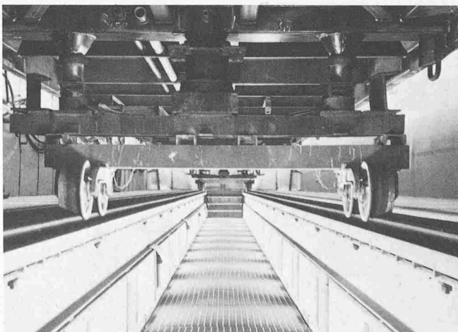
Bild 5b. Moderne Freistrahlanlage in einer schweiz. Waggonfabrik. Blick in den Laufgang für das Strahlen der Wagenunterseite. Die in die Seitenwände eingelassenen Zusatzbeleuchtungen sind gut sichtbar. Der Kasten des Personenwagens (siehe Bild 5a) sitzt auf zwei je vierrädrigen Transportschemeln. Man beachte: die Unterseite ist aus verschiedenartigen Profilen zusammengesetzt und ist deshalb stark verwinkelt (Werkphoto: Graber + Wening AG)
