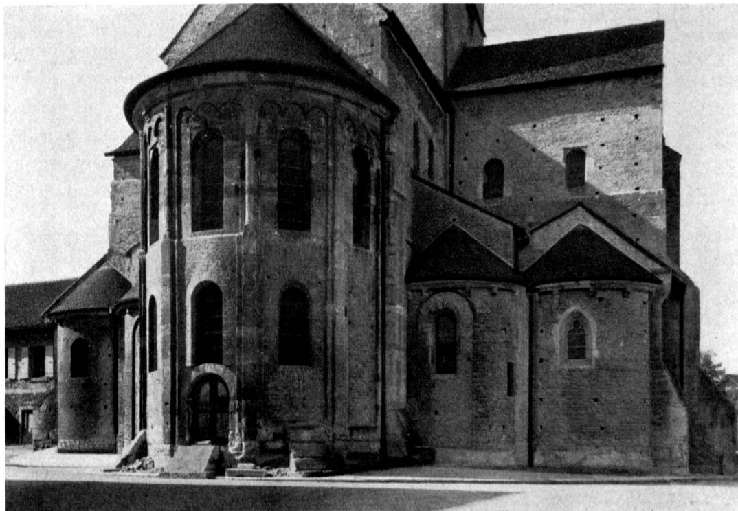
Payerne. Abbatale. Vue extérieure des parties orientales: chevet et transept
