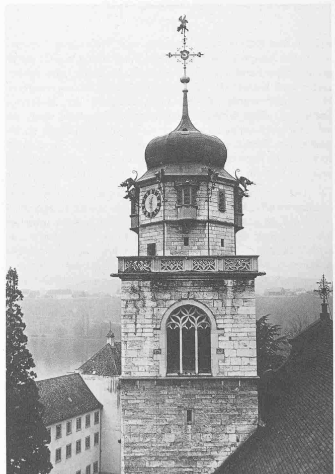
Der von Hans Wellenberg von Rheinau in den Jahren 1572 bis 1578 erbaute spätgotische Südturm vor der Restaurierung. Der Nordturm wurde 130 Jahre später durch Franz Beer in derselben Gestalt errichtet
