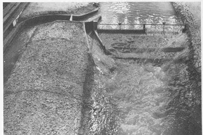
Bild 12. Wasserfassung Mollis/Linth (Lösung II) in Betrieb bei Q_L = 70 \text{ m}^3/\text{s}
