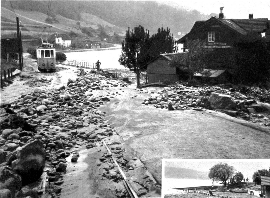
Ueberschwemmte Staatsstrasse Oberhofen
