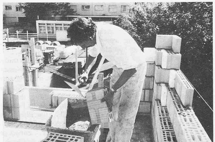
Bild 5. Der Mauermörtel soll gerade nass, dass er an der Kelle nicht klebt, und gerade trocken, dass er an den Steinen haftet, sein
