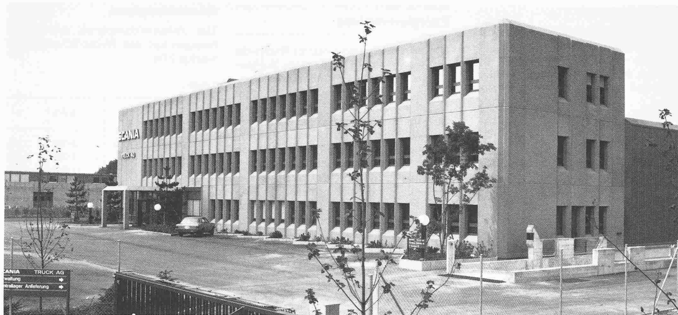
Ansicht des Bürotraktes von Südosten
