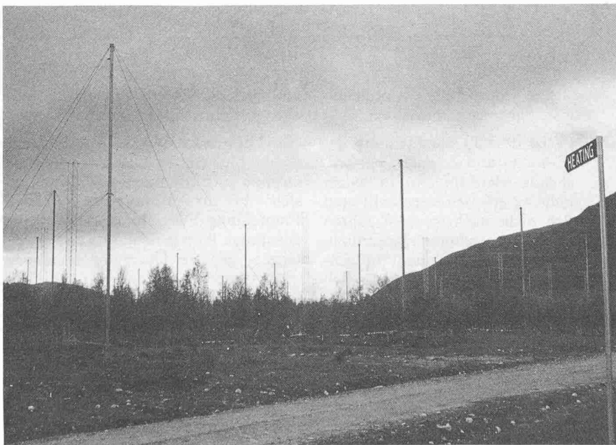
In einem weitläufigen Birkenhain des Ramfjordmoen-Tals steht ein «Wald» von Antennen: Die gekreuzten Dipole der Heating-Sendeantenne. Jedes Antennenfeld umfasst 36 gekreuzte Dipole, und drei Antennenfelder stehen zur Verfügung. Durch Phasensteuerung lässt sich die Richtung des Sendestrahls schwenken
