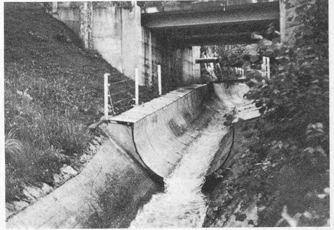
Bild 8. Mühlebach. Übergang Ortbetonschale zu Wellblechschale mit Werkstrassenbrücke
