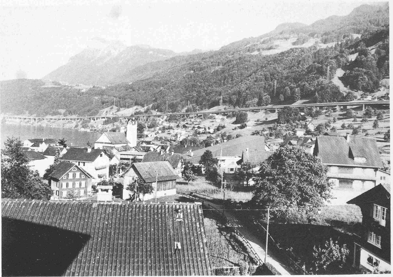
Auf einer Länge von 3148 Metern, gestützt auf 58 Pfeiler, zieht sich der Viadukt wie ein schmales Band über den topographisch und geologisch komplexen Hang zwischen Beckenried und dem Nordportal des Seelisbergtunnels
