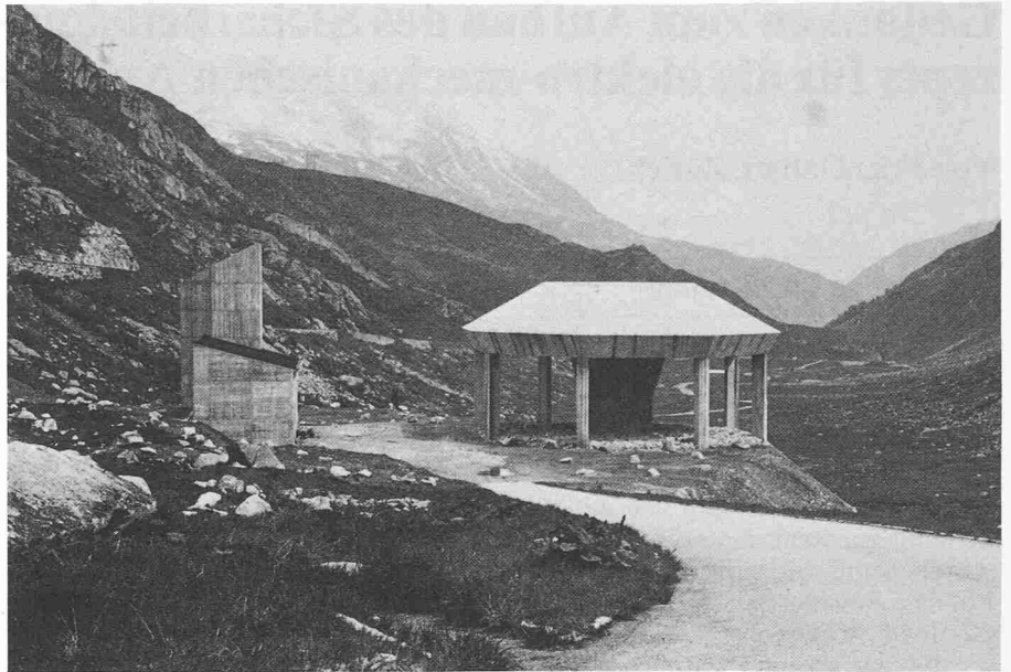
Bild 3. Aussenbauwerk Guspisbach, Ansicht von Süden
