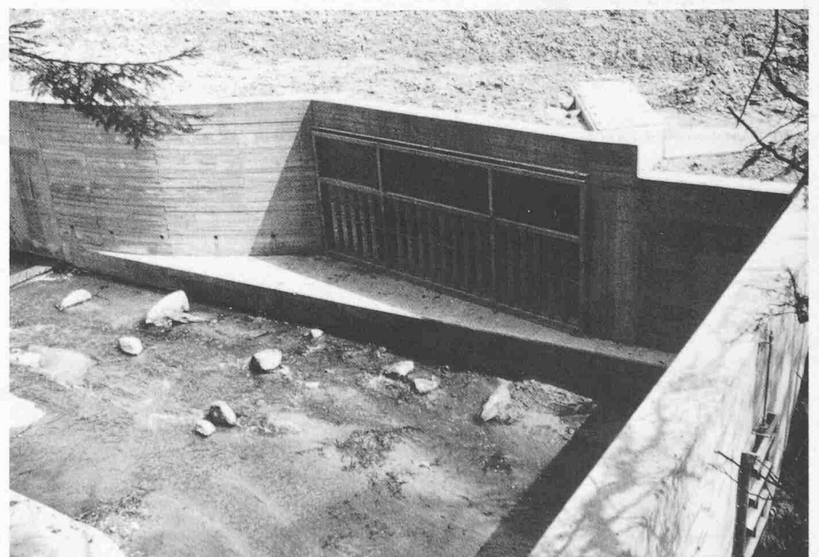
Bild 6. Einlaufbauwerk mit Überlaufschwelle und Rechen
