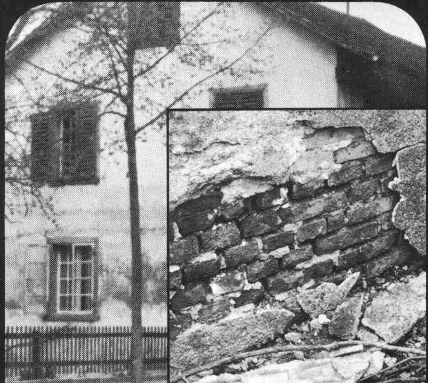
Renescon-Injektionen gegen aufsteigende Feuchtigkeit
