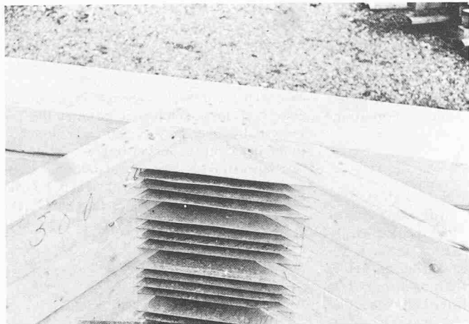
System Greim: In einteilige Stäbe, die eingefräste Schlitz aufweisen, werden Knotenbleche eingeschoben und durch Nagelung an die Hölzer angeschlossen (Foto: LIGNUM)
