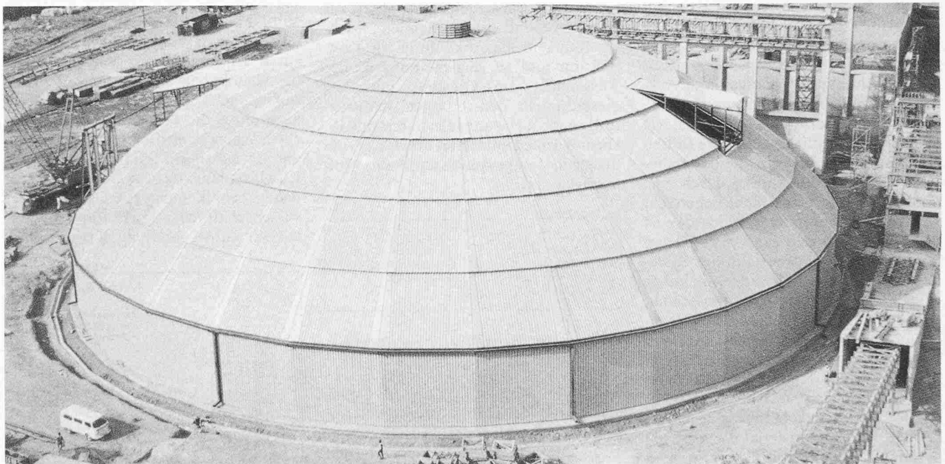
Bild 10. Der fertige Kuppelbau
