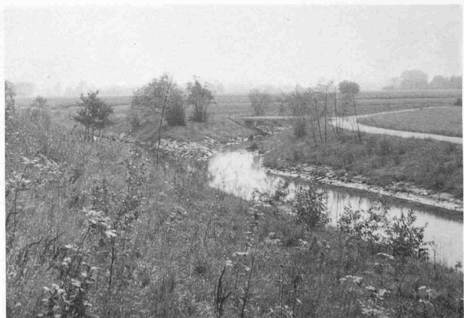
Bild 13. Hauptentwässerungskanäle in Aristau/Merenschwand (Bild: R. Maurer)
