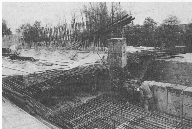
Bild 13. Produktionsstelle Widerlager Nord. Vorschoben mittels einer einzigen Presse (720 t), die am Mittelträger angesetzt ist
