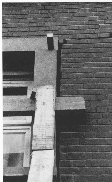
Bild 8. Die massive, seitliche Fenstereinfassung ist um mehrere cm verschoben. Dies deutet auf eine kurzzeitige Entlastung in vertikaler Richtung hin
