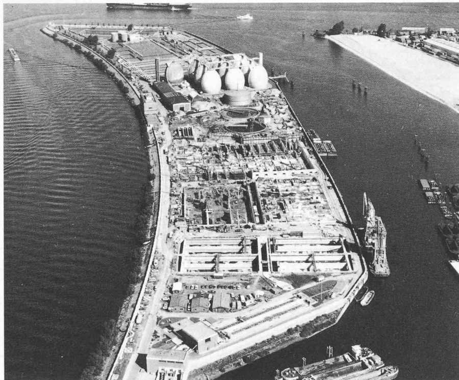
Bild 24. Hamburger Klärwerk Köhlbrandhöft auf einer künstlich geschaffenen Halbinsel in der Elbe (Freigegeben durch Luftamt Hamburg 922/81)
