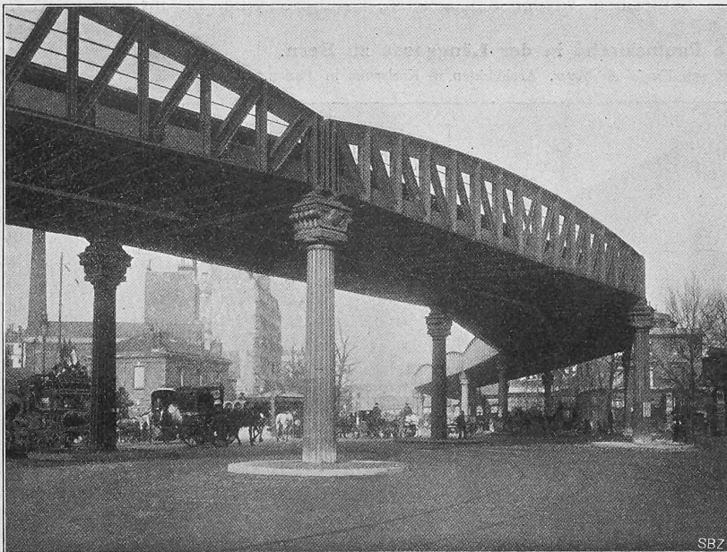
Abb. 7. Viadukt bei der Rue d'Allemagne. — Ansicht von unten.
