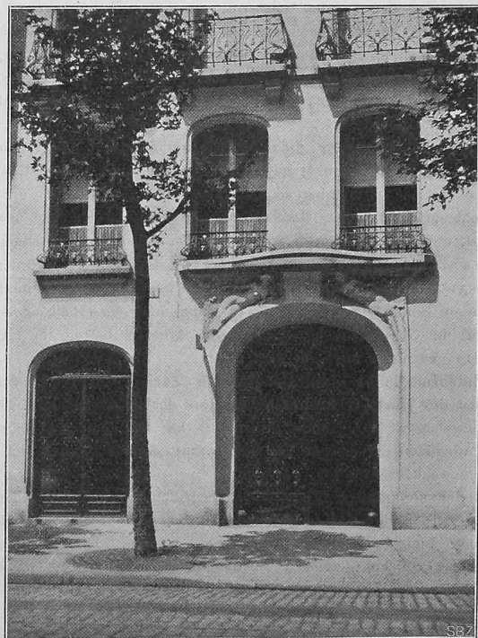
Abb. 6. Portal des Hauses Nr. 50 in der Avenue Victor Hugo.
