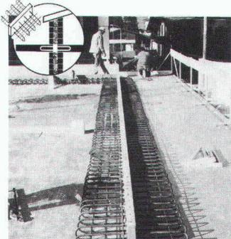
**Egco - wärmedämmender Kragplattenanschluss, stützenfrei**
