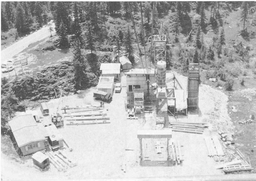
Bild 11. Talstation Bauseilbahn mit Basislager im Feldmoos an der Sustenstrasse
