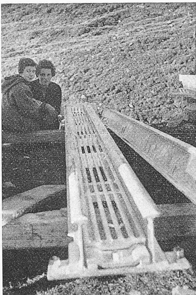
Bild 7. Fallrechen der Wasserfassung Fortunei (seit zwei Jahren in Betrieb)
