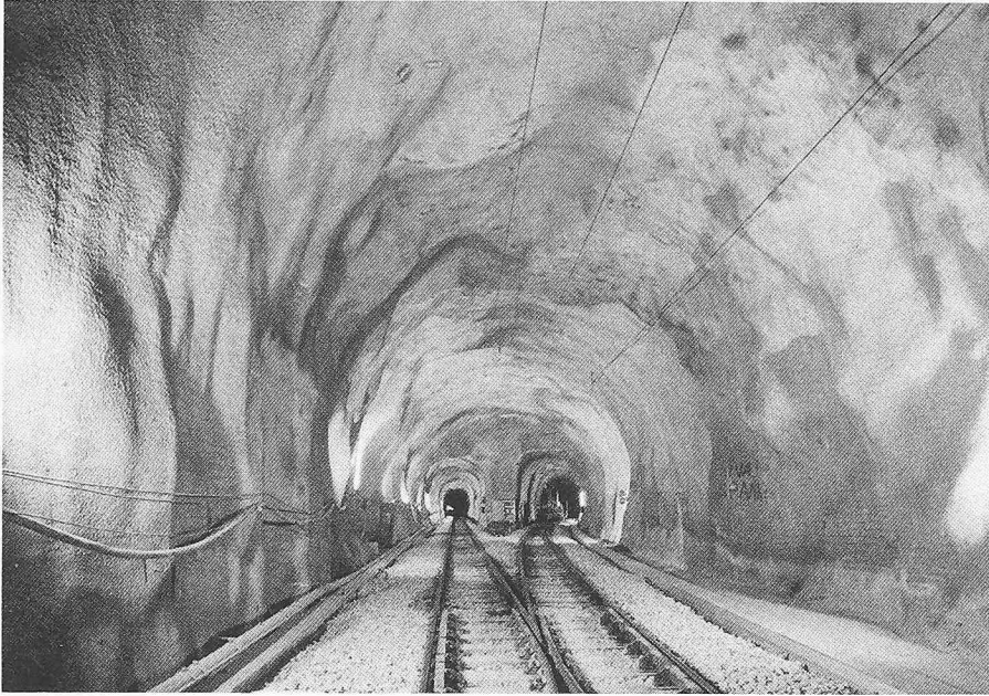
Bild 15. Erweiterungsbauwerk nach der Fertigstellung
