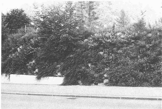
Bild 1. Kreuzbuchstrasse Luzern, Böschungssteine Typ «Big-Löffel»
