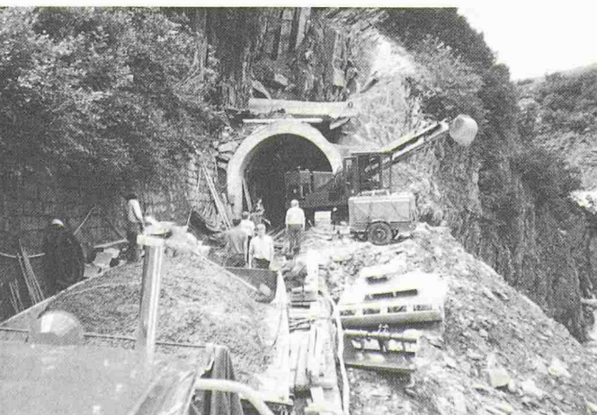
Alt-Senntum-Stafeltunnel III: Grosseinsatz (Bild: Archiv DFB)
