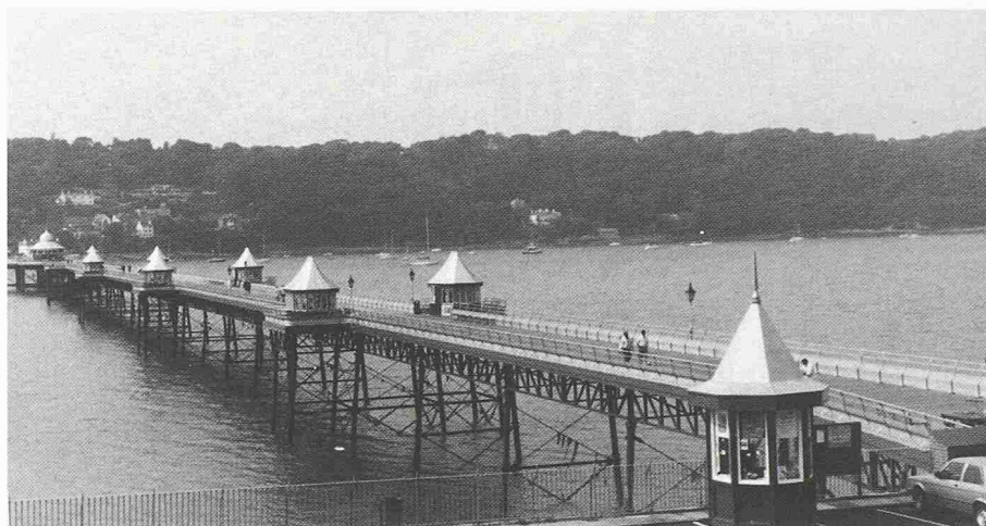
Bangor Pier, vor Zerfall gerettet durch Restaurierung 1983–88. Promenadensteg auf Pfählen, 500 m lang, 8 m breit, Tragwerk aus Gusseisen und Stahl, darüber Holzplanen. Gehört zu besterhaltenen Piers in Grossbritannien. Auf dem «Wasser spazieren» war der Wunsch der viktorianischen Gesellschaft, Pier-Architektur als Zeugnis einer Gesellschaftsform
