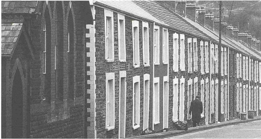
Penrhwyceiber, Dorfgemeinschaft mit Bergmanns-Cottage-Bauweise, zwei Räume unten, zwei oben, Bruchsandstein und Schieferdach, Zeugen einer vergangenen wirtschaftlichen Hochblüte
