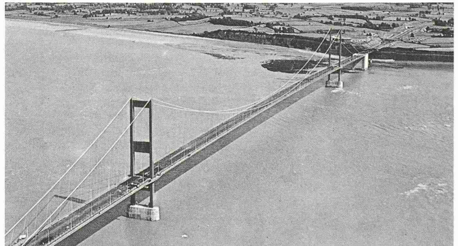
Brücke über die Severn-Mündung, Spannweite 1080 m, 1966
