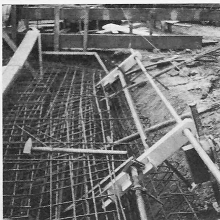
Armierung des Ankerjoches Wettingen mit den beiden Augenstäben
